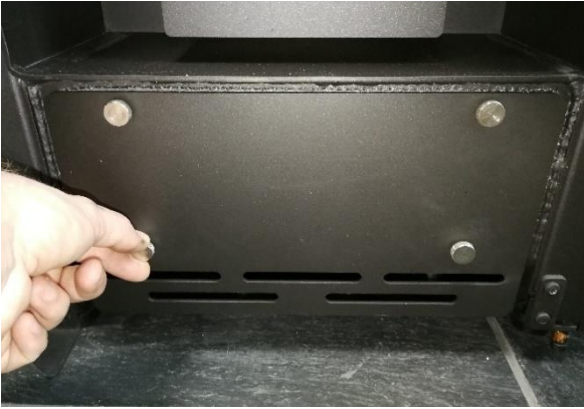
Kuva 1: Irrota ruuvit ja suojalevy savunohjauslevyn paikallistamiseksi.
