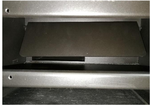
Afbeelding 2: controleer of de rookgeleiderplaat correct is geplaatst.
