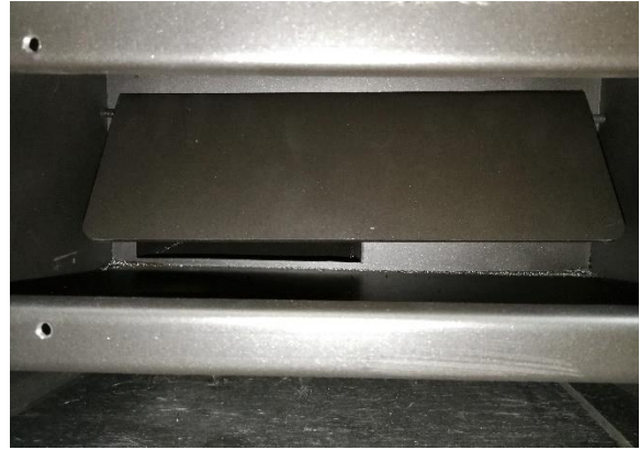
Billede 2: Tjek at røglederpladen sidder korrekt placeret på kroge.
