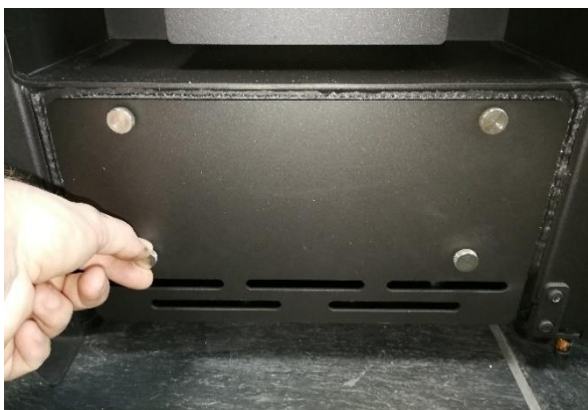
Kuva 1: Irrota ruuvit ja suojalevy savunohjauslevyn paikallistamiseksi.
